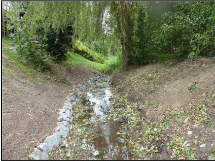
Abb. 3: Nach der Maßnahme: abgeflachte Böschungen, 26.08.2020
