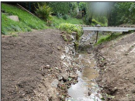
Abb. 4: Nach der Maßnahme: Böschungsfußsicherung in wasserwirtschaftlich erforderlichen Bereichen, 26.08.2020
